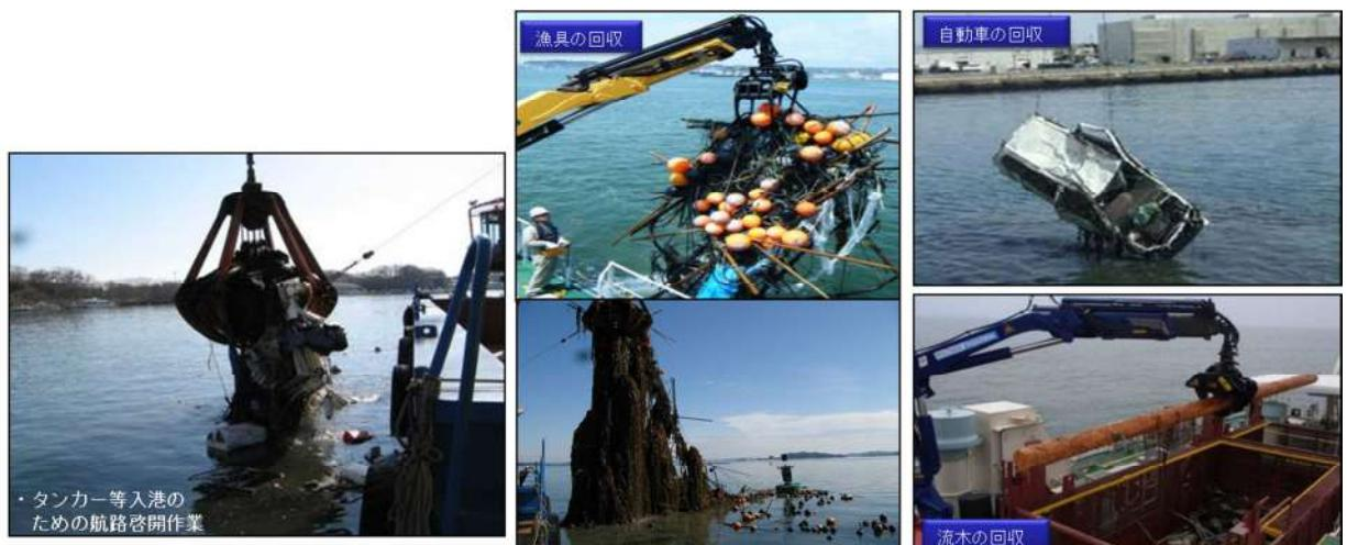
図－16 航路啓開における障害物除去作業への参画イメージ
