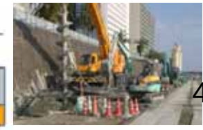
大淀川耐震対策(地盤改良)状況
