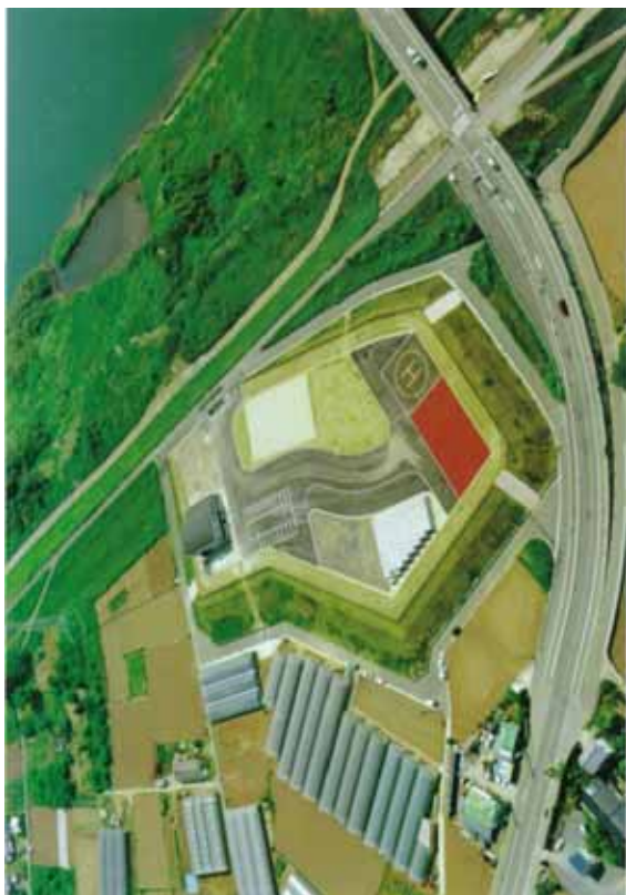
大野川防災ステーション
