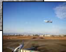
浸水の恐れがある宮崎空港 (出典:宮崎空港HP)
