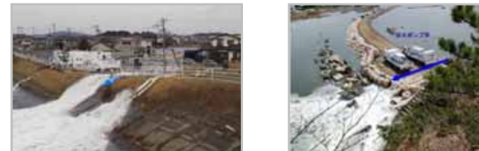
排水ポンプ車の活動状況 (東日本大震災)
